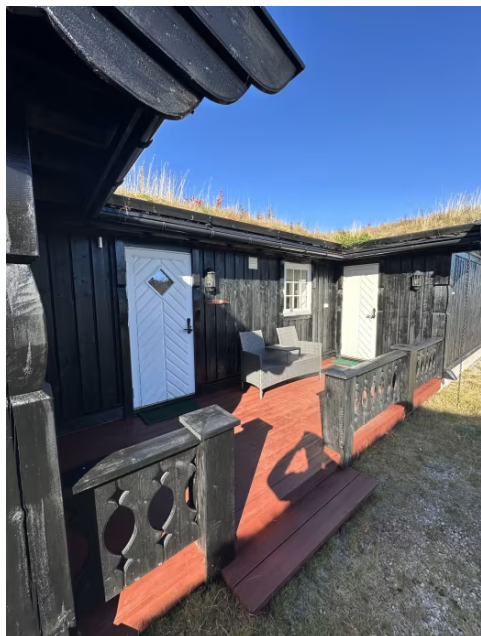
Viser terrasse ved inngangsparti.
