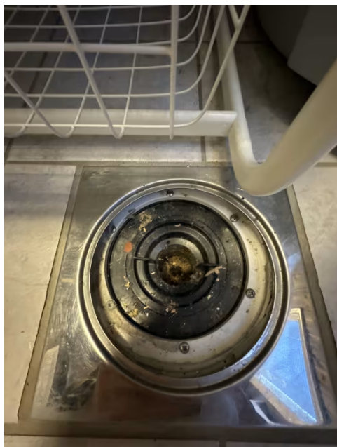
Viser sluk i gulv.
