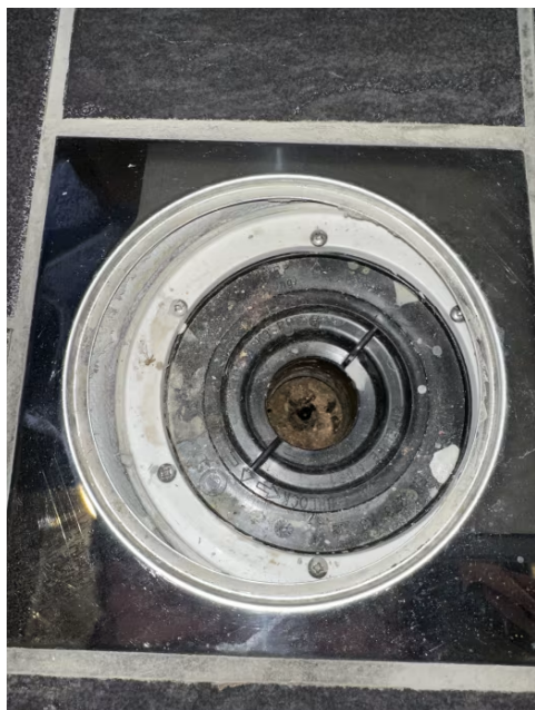
Viser sluk under innredning.
