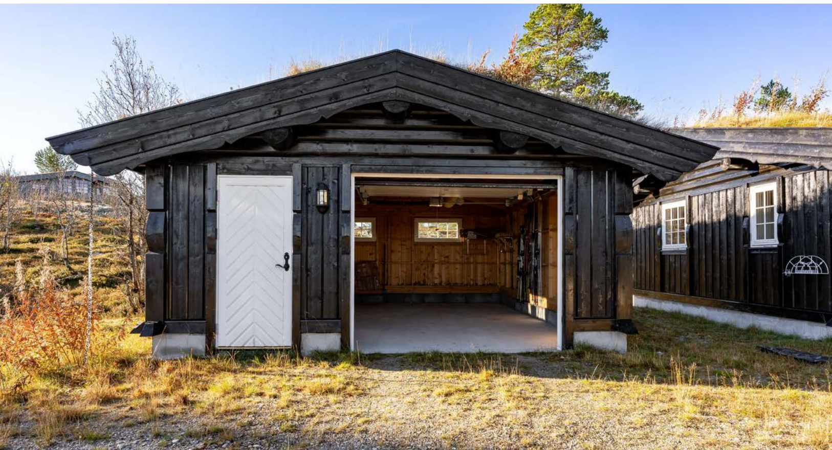
Garasje på 29m 2 med ytterdør i tre og leddport i metall med portåpner.
