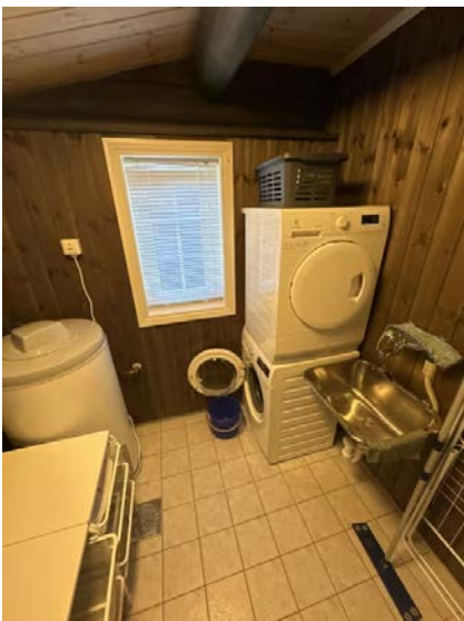
Viser installasjoner på vaskerom.
