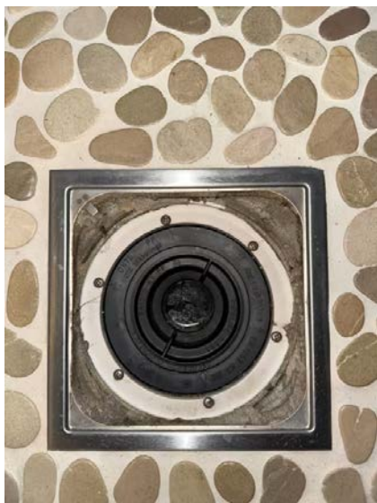
Viser sluk i dusjsonen.
