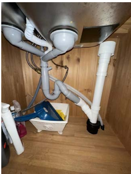
Viser vann og avløpinnstallasjoner
