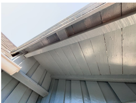
Del av takkonstruksjon.
