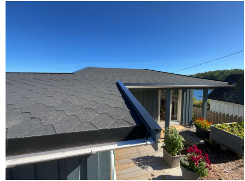
Del av taktekking.
