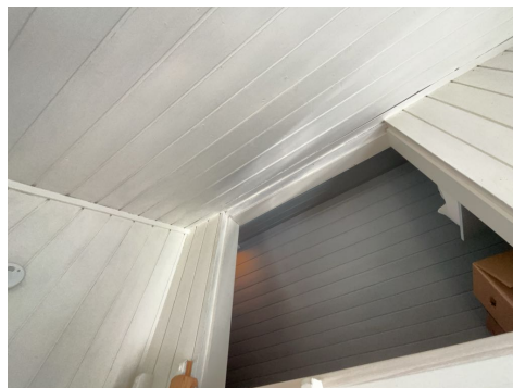
Tak sett fra innsiden.
