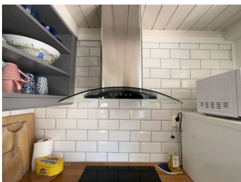
Montert avtrekk over steketopp.
