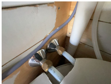
Del av rør til vann.
