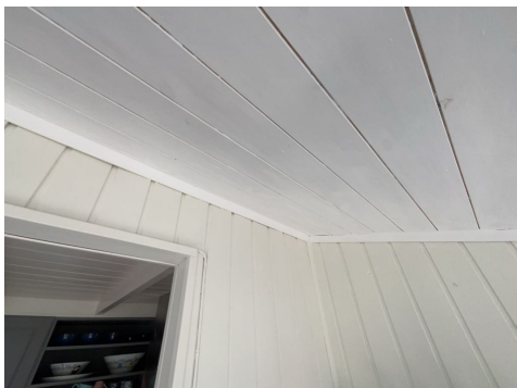
Del av vegg - tak.
