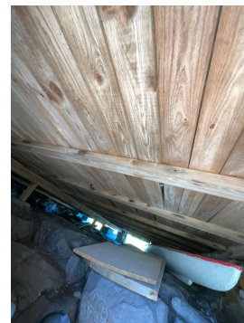
Del av etasjeskille sett fra undersiden.
