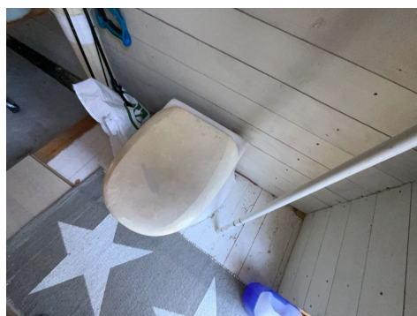
Eldre formulingstolett som fortsatt er montert i bod.
