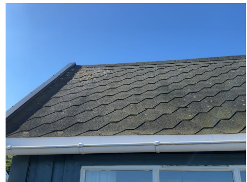
Del av taktekking.
