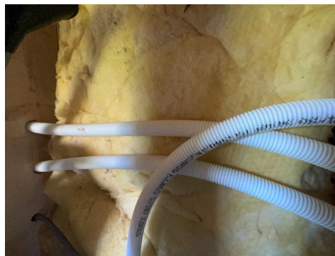
Del av rør til vann.
