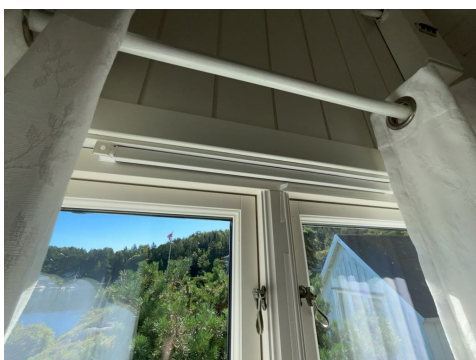
Eksempel på montert ventil i vindu.
