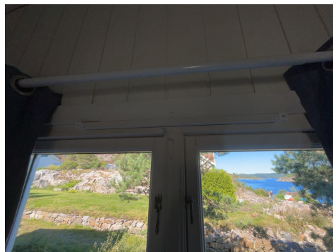
Eksempel på montert ventil i vindu.
