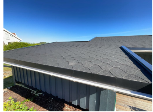
Del av taktekking.
