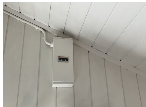
Inntak på vegg.
