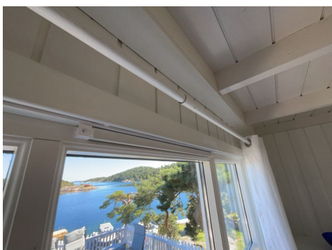
Eksempel på montert ventil i vindu.
