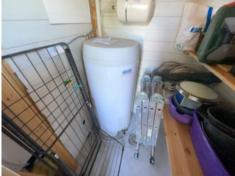
Varmtvannstank.
