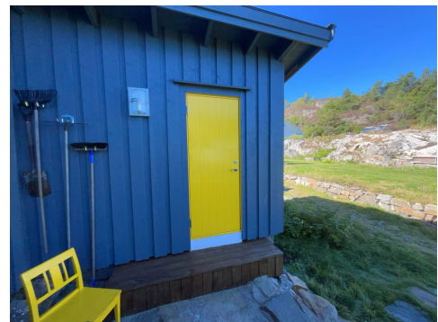
Dør inn til bod.
