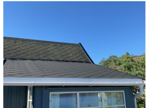
Del av taktekking.
