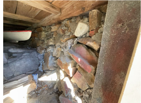
Pilar. Del av grunnmur.
