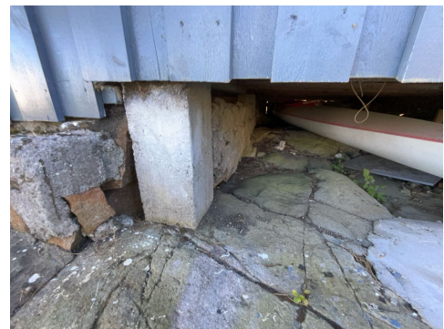
Pilar. Del av grunnmur.
