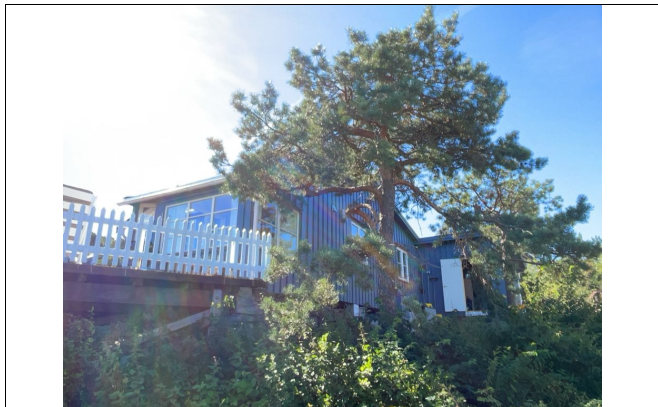
Hytte oppført på eiendommen.
