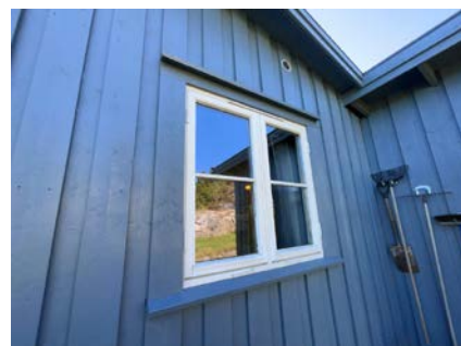
Eksempel på vindu i yttervegg.
