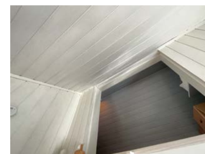
Tak sett fra innsiden.
