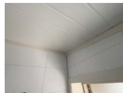
Del av vegg - tak.
