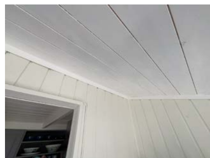
Del av vegg - tak.
