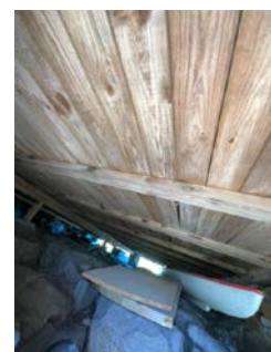
Del av etasjeskille sett fra undersiden.
