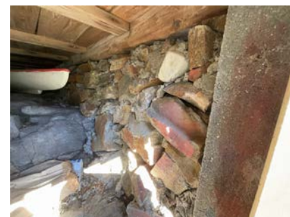
Pilar. Del av grunnmur.
