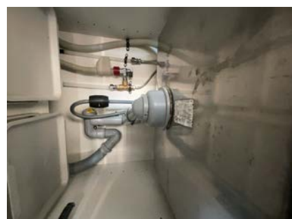
Del av rør til avløp.
