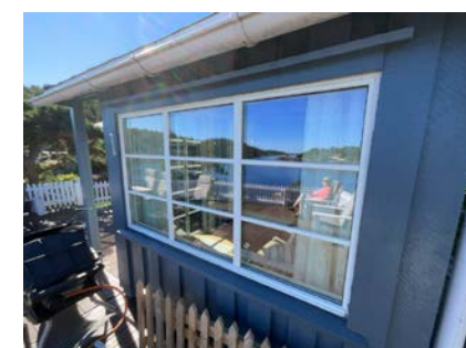
Eksempel på vindu i yttervegg.
