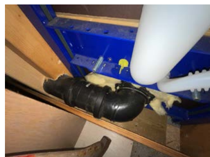
Del av rør til avløp.
