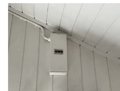
Inntak på vegg.
