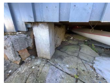
Pilar. Del av grunnmur.
