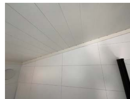
Del av vegg - tak.
