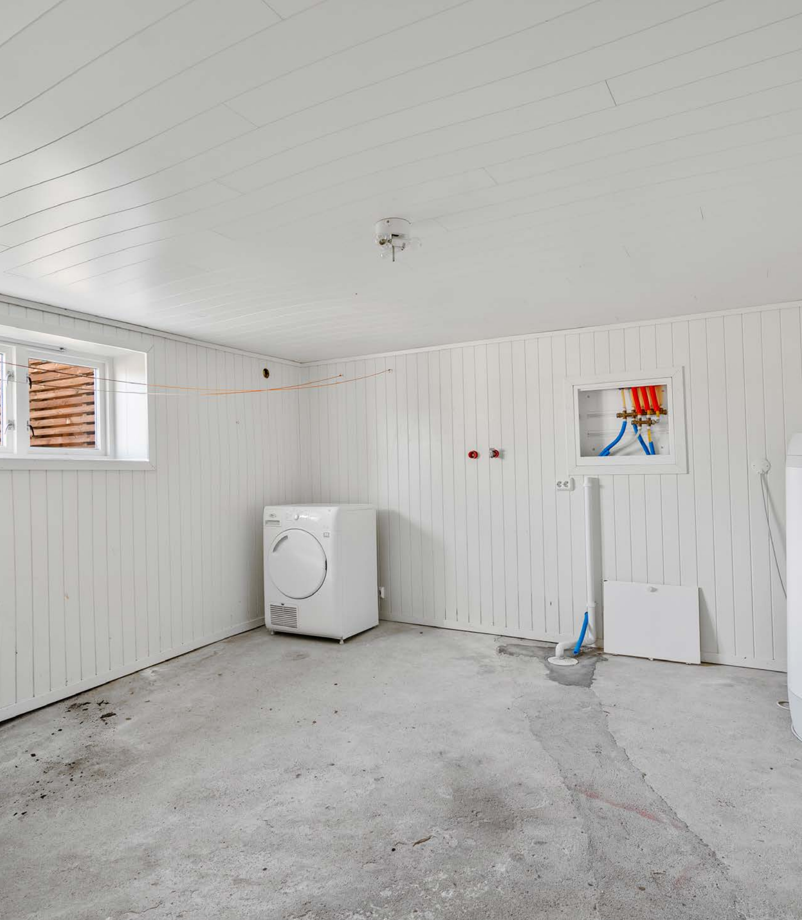
Kjeller utleiedel: Vaskerom, gang, boder.
