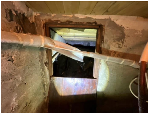
Løst inn til kryprom.
