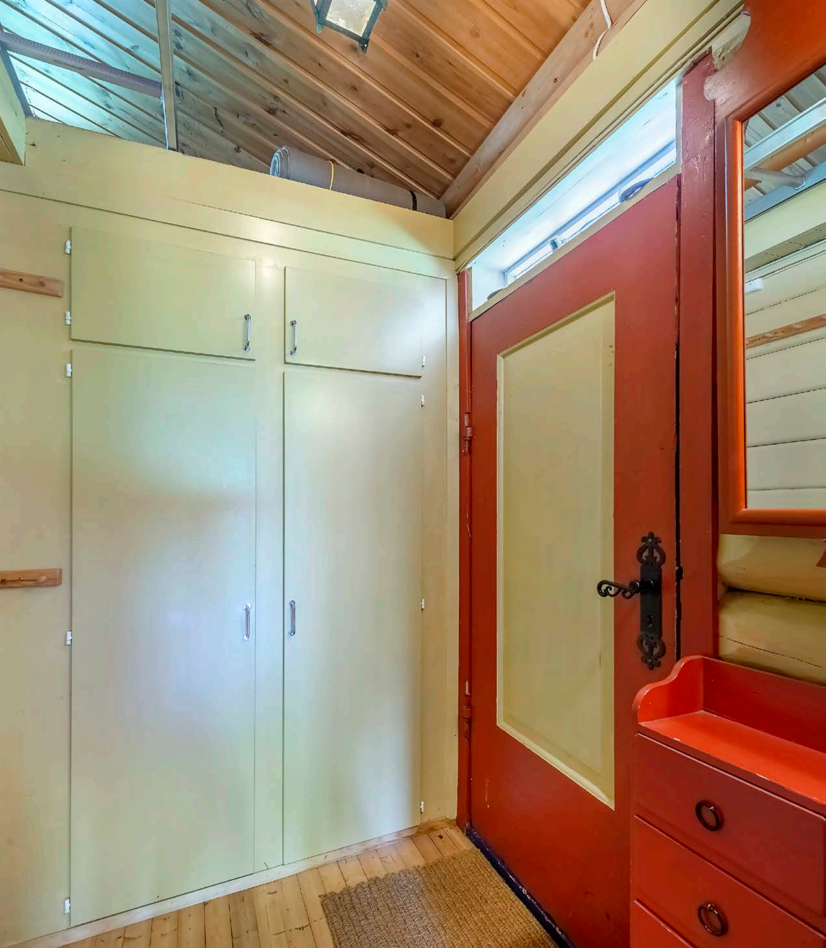
Vindfang med plassbygde skap
