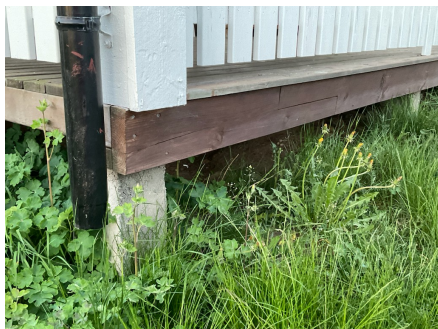
Overbygget terrasse fundamentert på betongsøyler.
