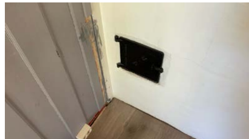
Det er i etterkant av befaringen lagt brannsikrer plate på vegg og gulv
