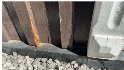
Hull i kledning trolig etter hakkespett.
