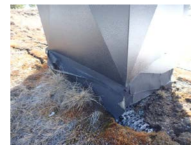
Bilde av tettebånd ved pipe.
