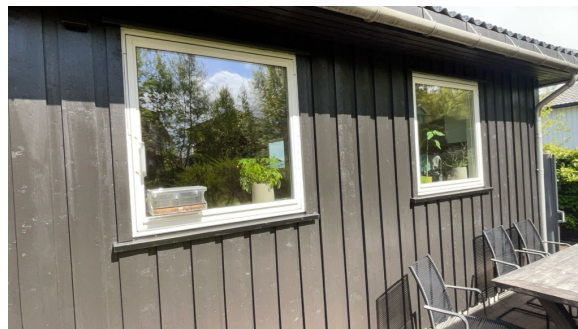
Vindu på kjøkken fra 2013
