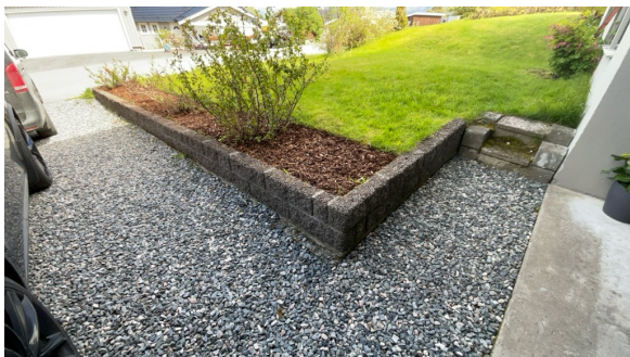
Mur av splittblokklettklinkerblikk
