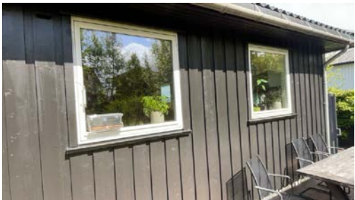
Vindu på kjøkken fra 2013
