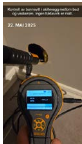
Kontroll av bunnsvill i skillevegg mellom bad og vaskerom. Ingen fuktavvik er målt
