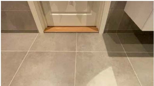
Oversikt mot dør til vaskerom
