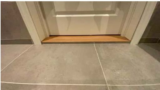
Tilluftsspalte under dør
