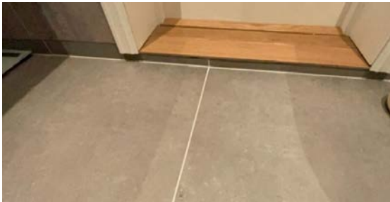
Oversikt mot dør inn til soverom
