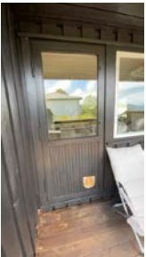
Verandadør med utgang fra stue. Tidligere katteluke er fjernet og tettet utvendig med plate etter befaringen
