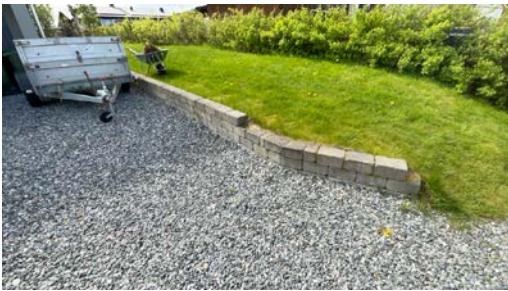
Støttemur av Betongstein
