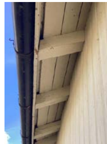
Flere sperre er skjøtet på på et tidspunkt av tidligere eiere.
