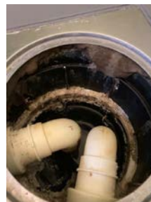
Tetthet og membran kan ikke verifiseres.
