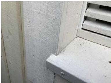
Omramming ført helt ned på vannbrett.
