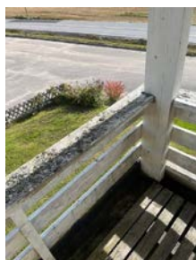
Eksempel på tilstand på rekkverk på balkong.
