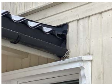
Utett inn i veggkonstruksjon over vindu.
