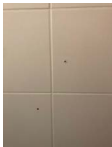
Eksempel på perforering i vegg.
