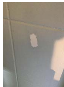
Eksempel på avsaling av maling.
