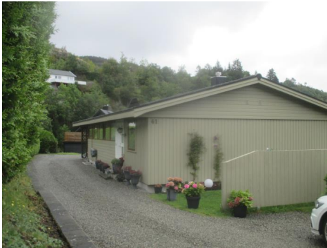
Endevæggen er blitt kledd på nytt.
