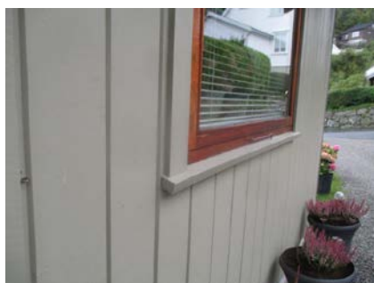
Deler av kledningen med tilhørende belistninger.
