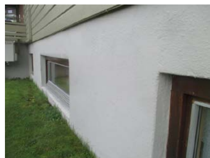
Deler av grunnmur.
