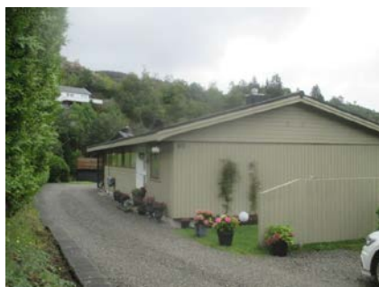
Endeveggen er blitt kledd på nytt.
