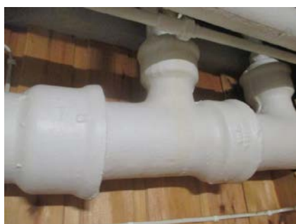
Avløpsrør i fra byggeåret.
