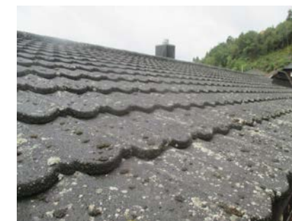
Deler av taktekkingen.
