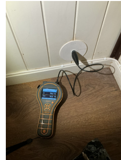
Bilde fra fuktmåling i utlektet veggkonstruksjon.
