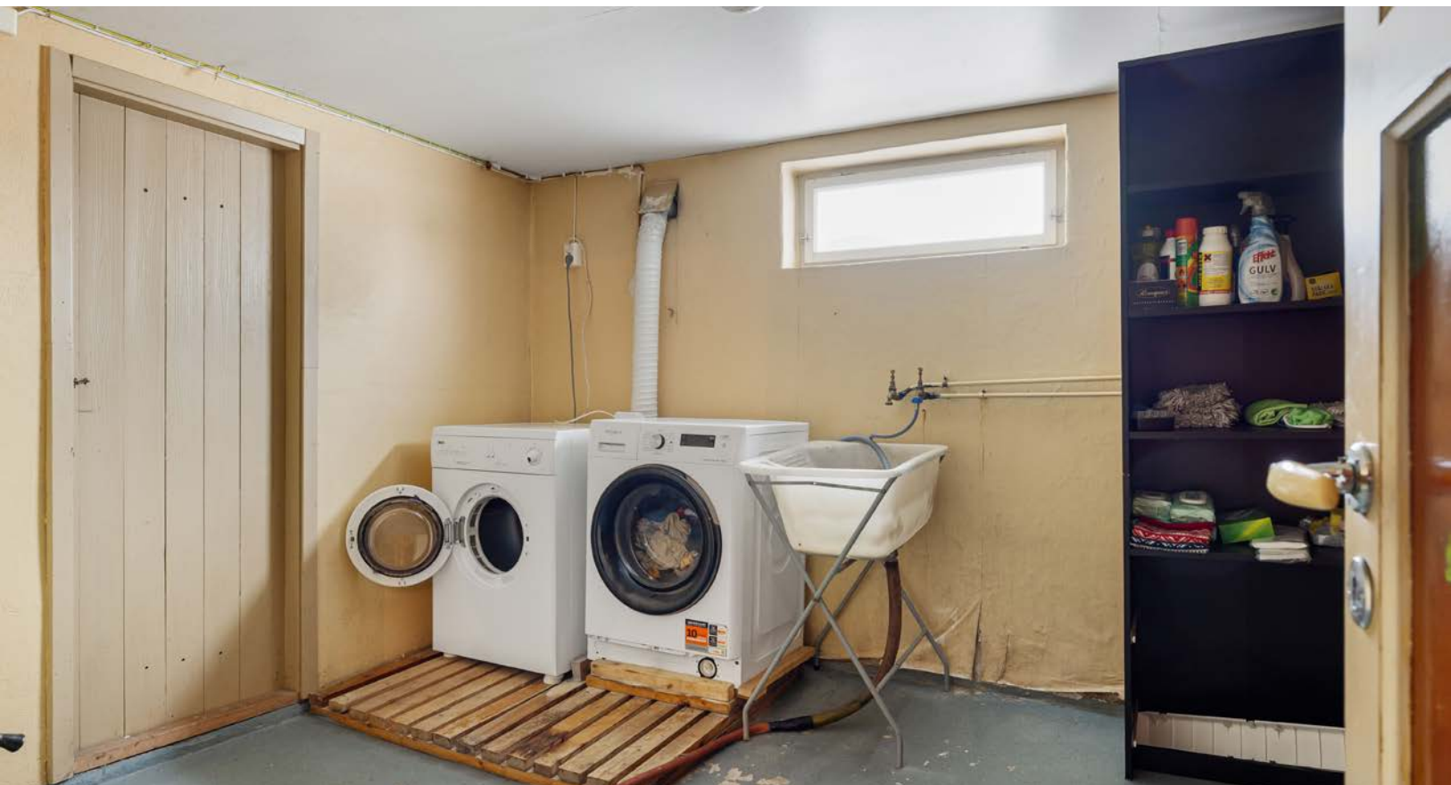
Vaskekjeller fra byggeår uten fremlagt dokumentasjon. Rommet har malt/behandlet betong på gulv, vegger av tapetsert og malt mur, samt vedovn som varmekilde.
