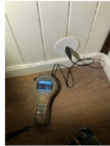
Bilde fra fuktmåling i utlektet veggkonstruksjon.
