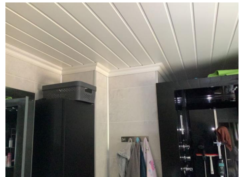
Bildet viser at deler av pipe er innkledd på badet.
