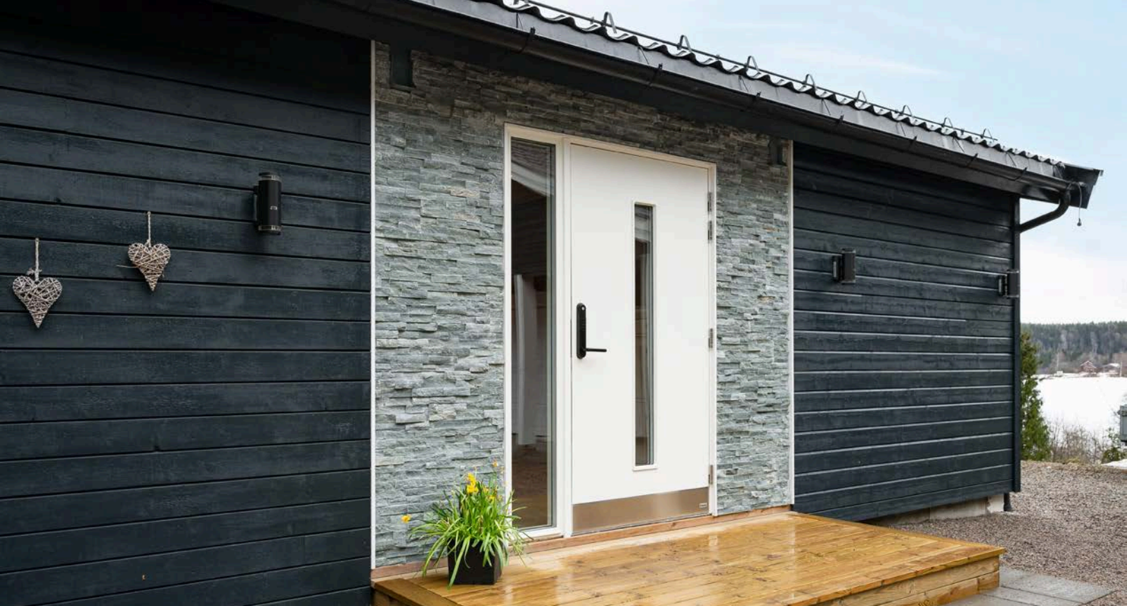
Pent inngangsparti. Det er installert Yale Doorman smartlås som gir deg praktisk nøkkelfri tilgang til huset.
