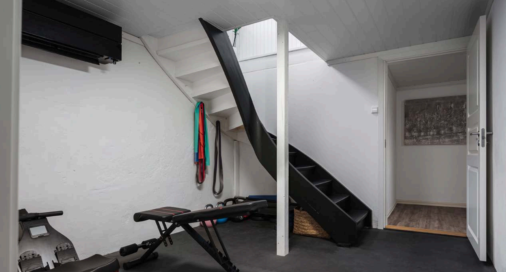
Kjellergangen er brukt som et trimrom. Her er det montert varmepumpe.
