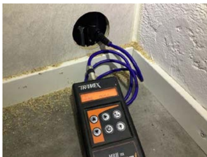
Bildet viser hulltaking og at det måles tørrt.
