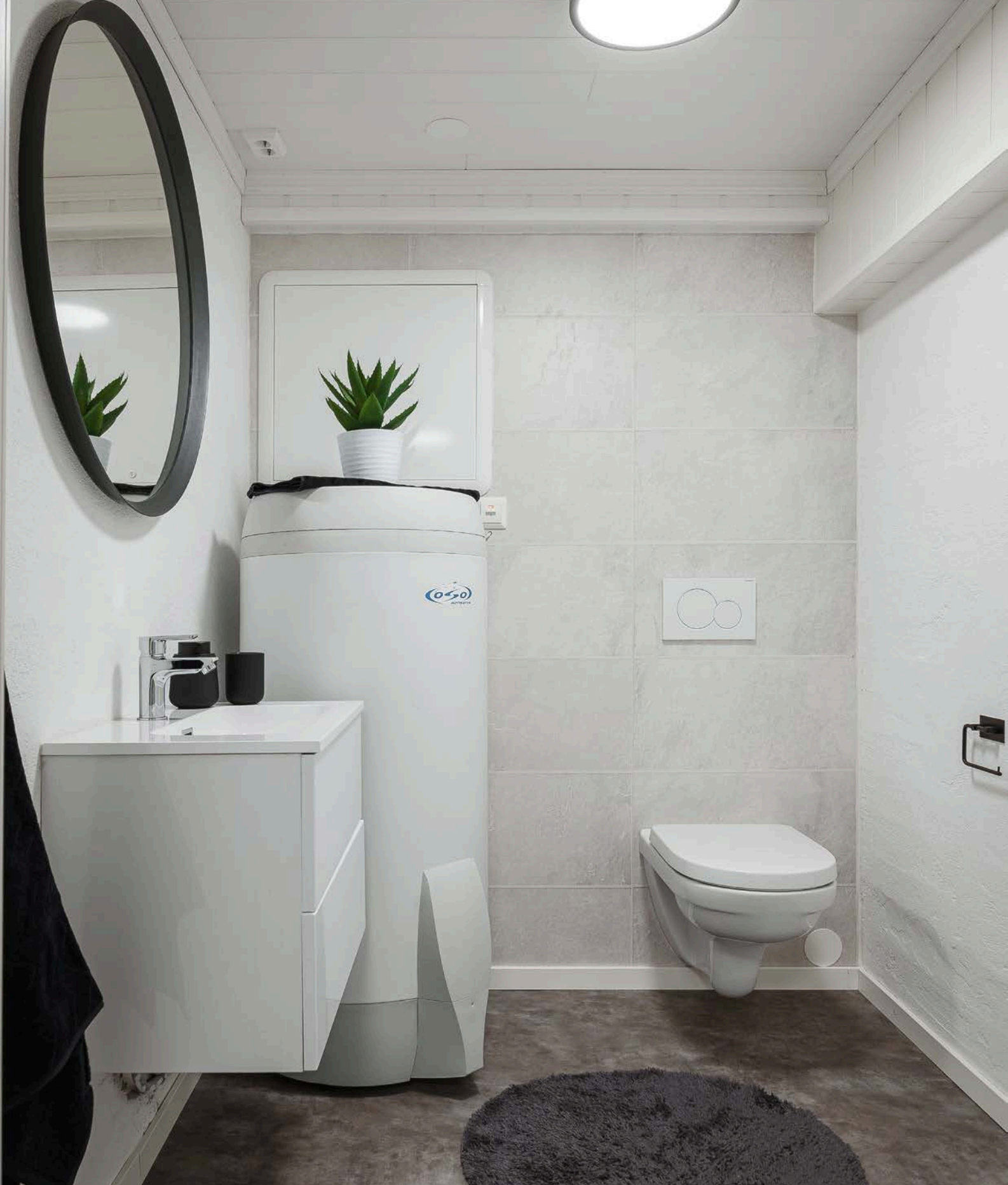
WC i kjeller har gulvbelegg på gulv og baderomsplater og malt mur på veggene. Det er veggmontert toalett og servant. Naturlig ventilasjon gjennom ventil i himling.
