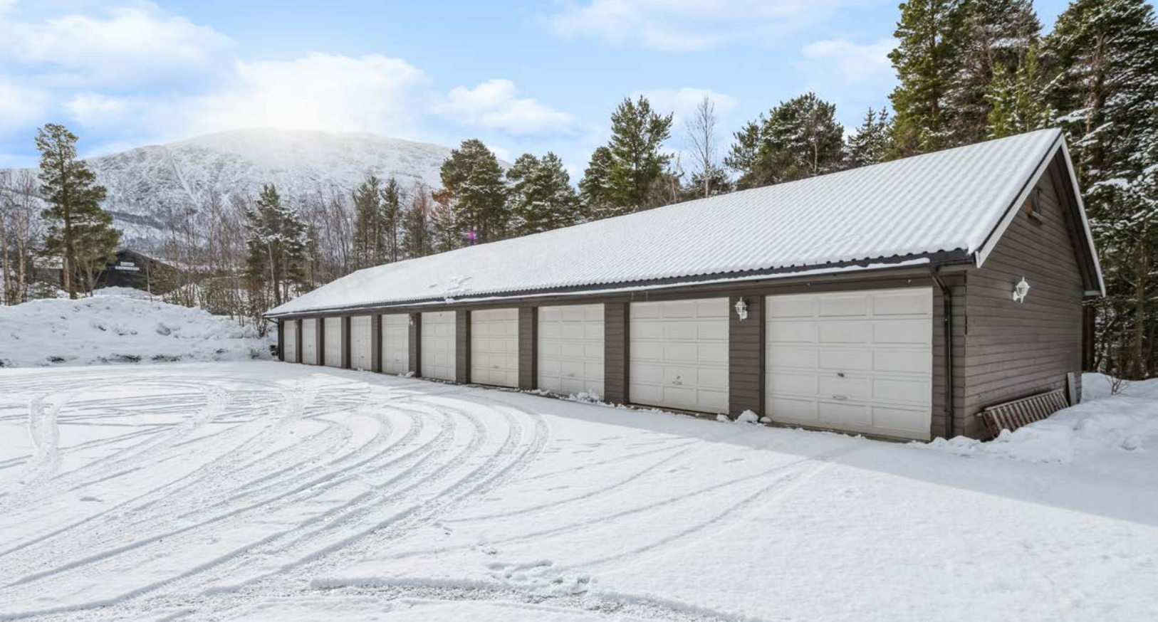
Felles garasjerekke hvor leiligheten disponerer garasje med romslig bod i bakkant Garasjen har leddport med motorisert åpner
