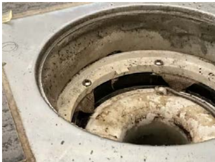
Hull/åpning i overgang klemring/membran.
