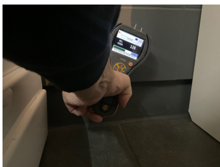
Fuktmåling på overflate i dusjsone. Vegg
