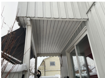
Undersiden av terrasse.
