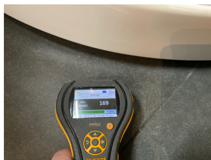
Fuktmåling på overflate i dusjsone. Gul
