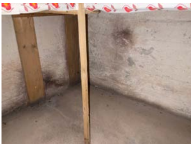
Fuktskjolder på vegg i kjeller.
