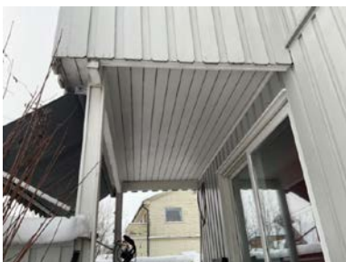
Undersiden av terrasse.
