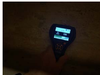
Fuktmåling på vegg i kjeller.
