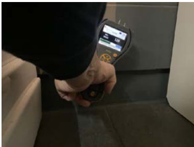
Fuktmåling på overflate i dusjsone. Vegg
