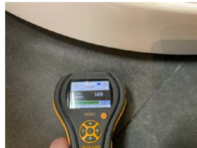
Fuktmåling på overflate i dusjsone. Gul
