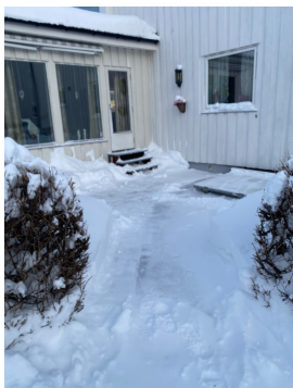
Terrassen var snødekt på befaringsdagen
