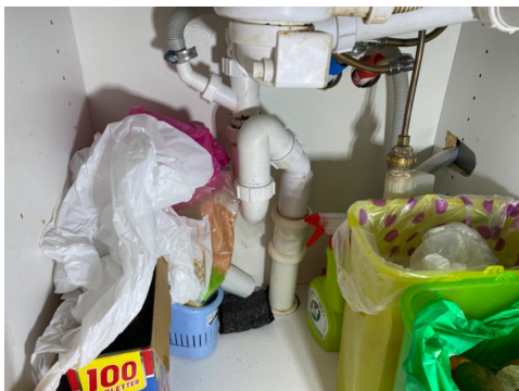
Kontroll av røropplegget.
