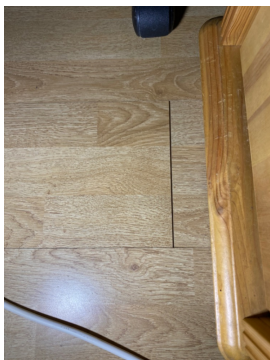
Stedvis tørkesprekker i skjøte på laminat og parkettgulv
