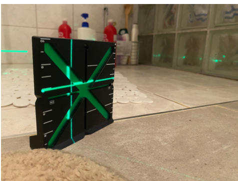
Måling av fallforhold til dusjnisje
