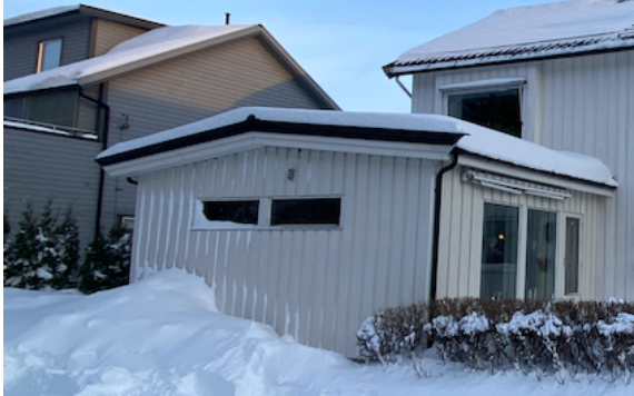
Snødekt tak på befaringdagen.
