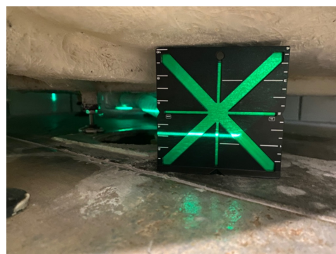
Måling av planavvik til sluk.
