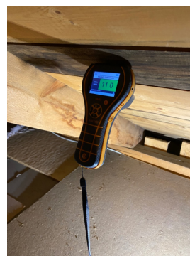
Fuktmåling i takkonstruksjon viste ingen forhøyede fuktverdier.
