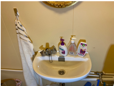
Veggplater i sonen bak vask bør fuktsikres.
