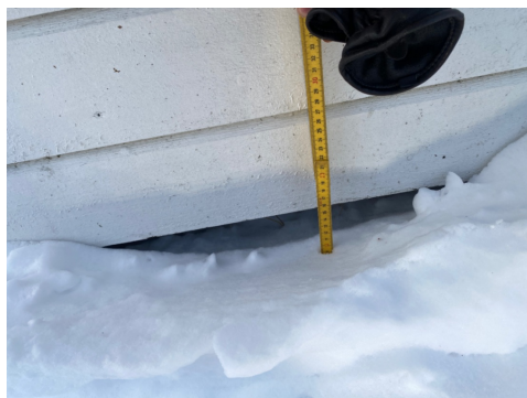
Kledningsbord mot hovedinngangstrapp
