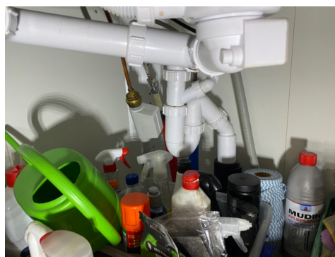
Kontroll av røropplegget.
