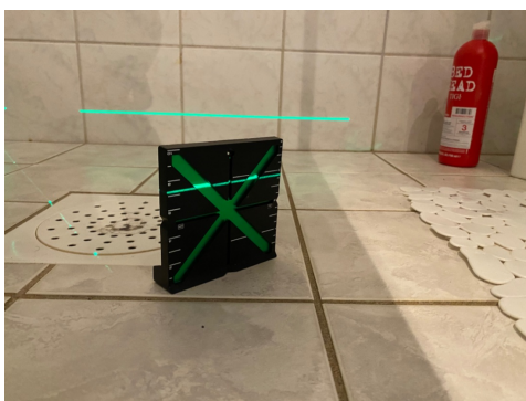
Maling av fallforhold til sluk
