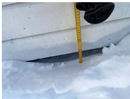
Kledningsbord mot hovedinngangstrapp
