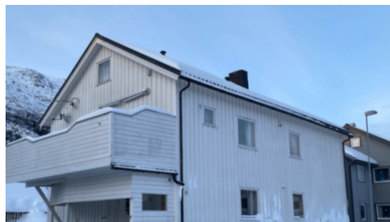
Taket var snødekt på befaringsdagen.
