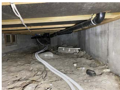
Fuktmåling viste ingen unormale forhold.
