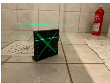
Måling av fallforhold til sluk
