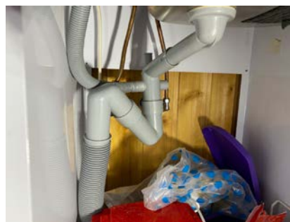
Kontroll av røropplegget.
