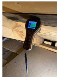
Fuktmåling i takkonstruksjon viste ingen forhøyede fuktverdier.
