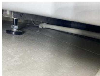
Sluket under boblekar har begrenset tilgang for rengjøring
