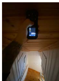
Frihøyde i trappen målt til 1.64 m.
