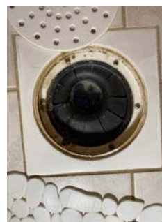
Sluket under boblekar har begrenset tilgang for rengjøring
