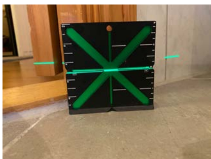
Måling av fallforhold fra dør.
