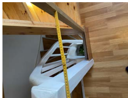
Åpninger i rekkverk skal inntil en høyde på 0,75 m i trappeløpet være maksimum 0,10 m
