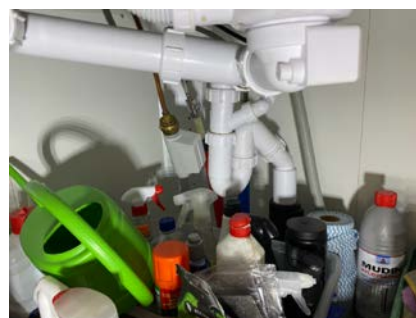
Kontroll av røropplegget.
