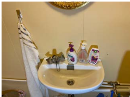
Veggplater i sonen bak vask bør fuktsikres.
