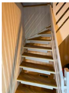
Trapp med oppgang fra kjellerstue
