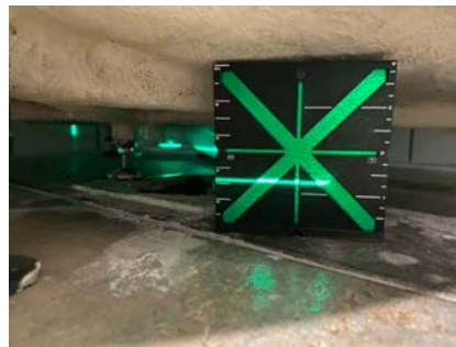
Måling av planavvik til sluk.
