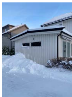
Deler av muren var snødekt ved befaringsdagen og er dermed begrenset inspisert
