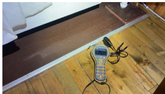
Ved fuktmåletaking av gulv inne på badet er det ikke fuktutslag
