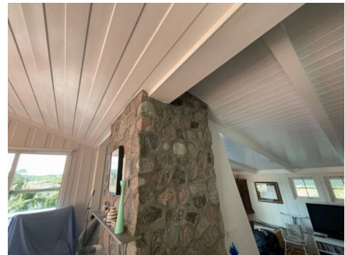
Utsnitt pipegjennomføring.
