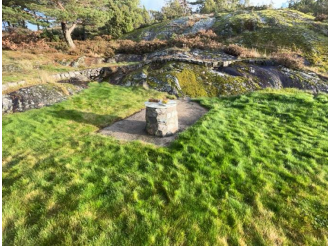
Vannsamler/sisterne på eiendommen.
