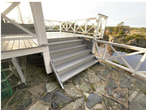
Utvendig trapp i tre.
