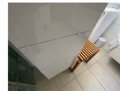
Noe merker på baderomsinnredning.
