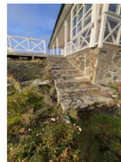
Utvendig trapp i naturstein og betong.
