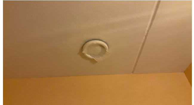
Test av avtrekk. Papiret henger.
