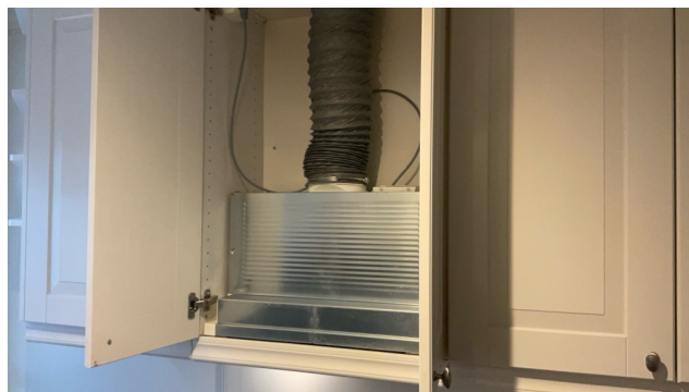
Ventilator med kullfilter.
