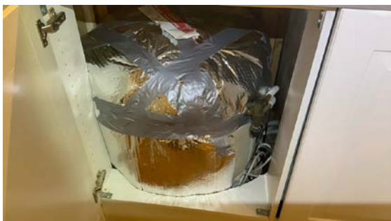
Bereder montert under kjøkkenbenk.
