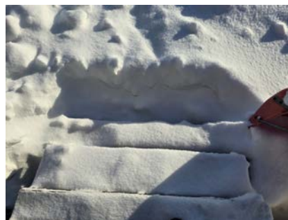
Begrenset vurdert utvendig trapp.
