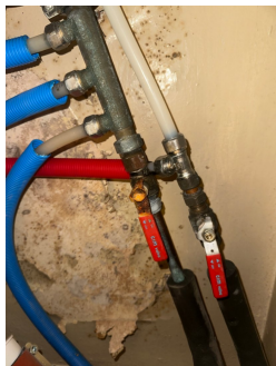
Stoppekranner plassert på bad, irr og rust på vannrør
