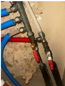
Stoppekraner plassert på bad, irr og rust på vannrør
