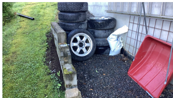
Liten støttemur av betongstein ved garasje.
