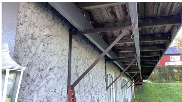
Knekter har innfesting i spikerslag for fasadeledning.
