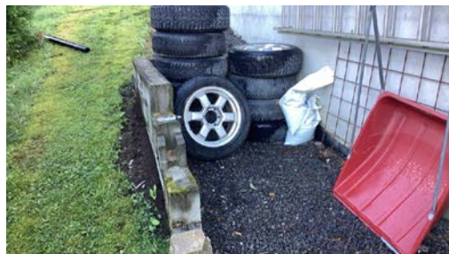
Liten støttemur av betongstein ved garasje.
