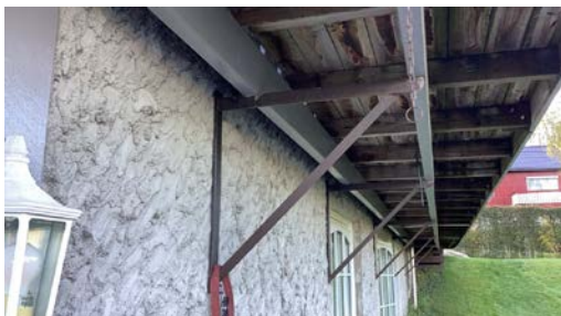
Knekter har innfesting i spikerslag for fasadekledning.
