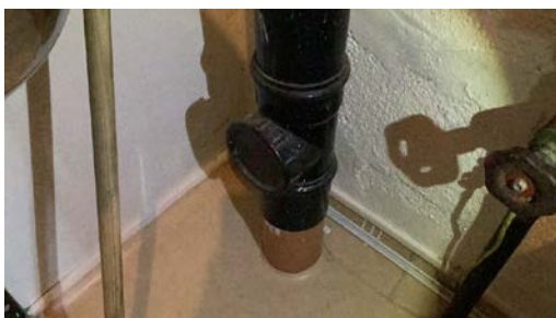
Stakepunkt på vaskerom.
