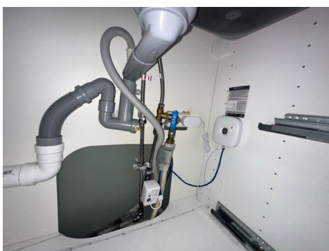
Rørøpplagg i kjøkkenbenk med Waterguard
