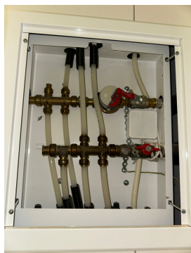
Rørøpplagg i kjøkkenbenk med Waterguard
