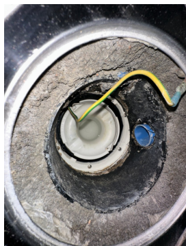
Plastsluk med klemring for membran
