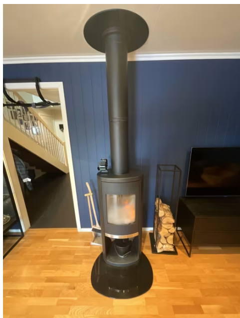
Viser ildsted montert i stue.
