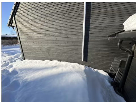
Store deler av ringmur var snødekt på befaringen og er ikke kontrollert.
