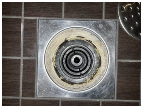
Viser sluk i dusjsonen.
