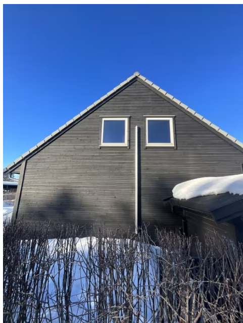
Brannstige på gavlvegg tilknyttet soverom i 2.etasje.
