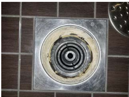
Viser sluk i dusjsonen.
