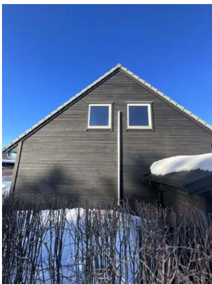
Brannstige på gavlvegg tilknyttet soverom i 2.etasje.
