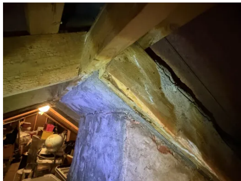
Eldre takkonstruksjon oppført med sperrer.
