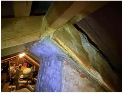
Eldre takkonstruksjon oppført med sperrer.
