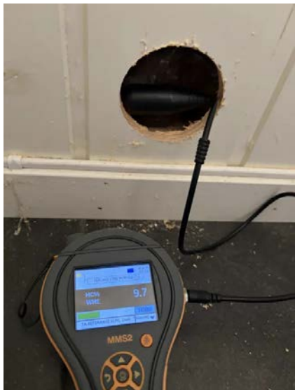
Undersøkelsen i utforet vegg ved trapp viser ingen tegn til skader.
