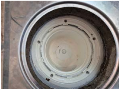
Sluk under dusjkabinett.
