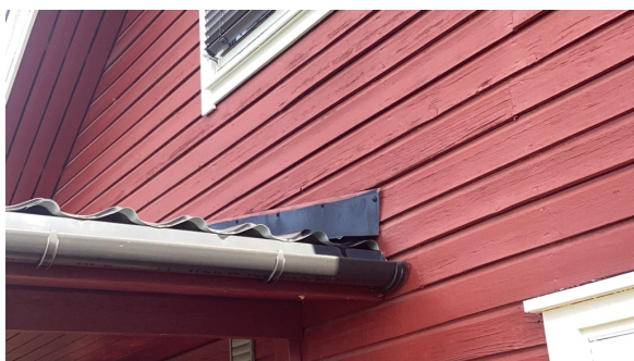
Beslag er lagt utenpå kledning.
