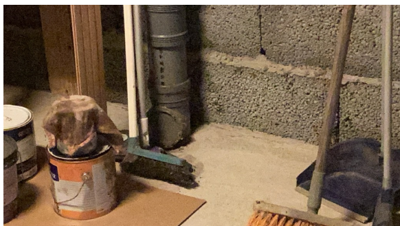
Stakepunkt i kjeller.
