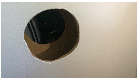
Adkomst til stoppekran.
