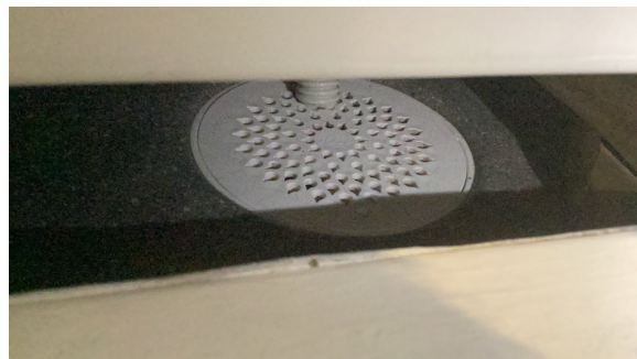
Sluk med klemring i nisje.
