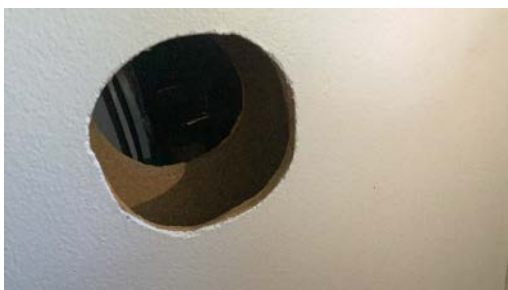
Adkomst til stoppekran.
