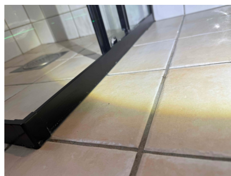
Bildet viser skinnen til dusjdørene mot gulvet.
