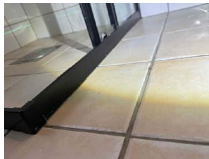
Bildet viser skinnen til dusjdørene mot gulvet.
