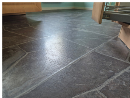
Sveller på kjøkkengulv.
